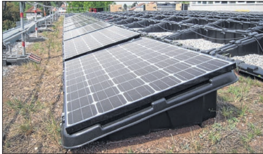
Der Bau der Fotovoltaikanlage auf dem Dach des Hallenbads hat begonnen. Das Dach hat eine ideale Ausrichtung für die Gewinnung von Solarstrom.
